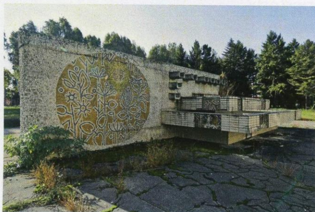
Trnava, 1981 – Kamenná mozaika fontány v areáli Gynekologicko-pôrodnického pavilónu nemocnice, Trnava, 50 m 2 , J. Martin
